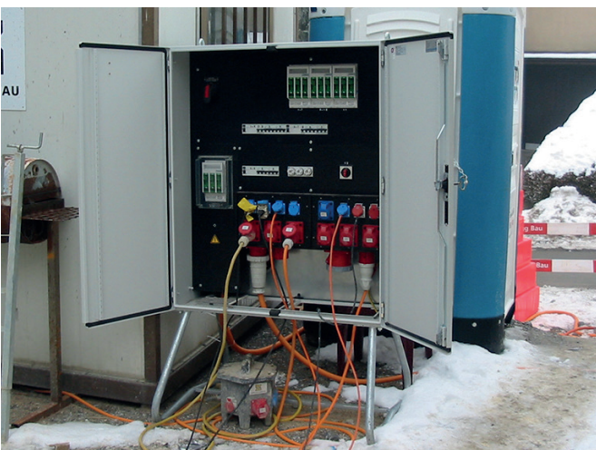
Distributore principale in cantiere
